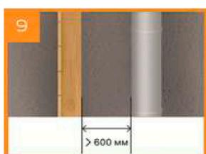
Деревянные поверхности, расположенные в непосредственной близости от дымоходных труб, следует обработать антипаренами. Если расстояние от дымохода до стены менее 500 мм - применяются дополнительные элементы - отражатели, экраны, фиброкементные плиты.
